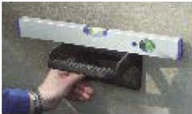
Steigeisen ausrichten.
