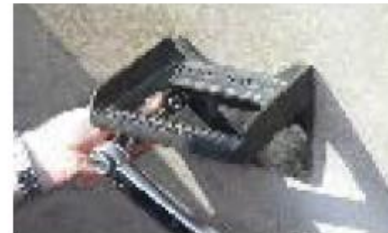
Steigeisenanker setzen und mit Drehmomentschlüssel T_{inst} = 25 \text{ Nm} aufbringen.
