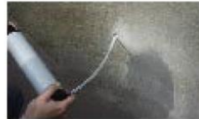
Bohrloch reinigen.
