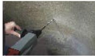
Bohrloch erstellen.
