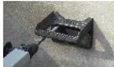
Zweites Bohrloch erstellen und reinigen. Steigeisen dient als Schablone.
