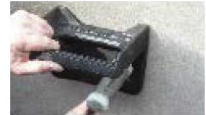
Steigeisenanker durch die Bohrung im Steigeisen im Durchsteckverfahren setzen.
